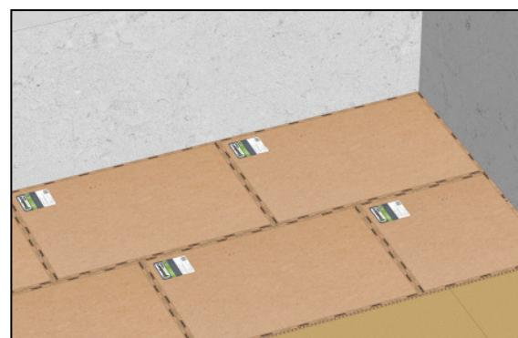
**3** Швы между панелями и стенами заполняются герметиком **SoundGuard Seal**, а стыки между панелями заполняются герметиком **SoundGuard Seal** и проклеиваются самоклеющейся лентой **SoundGuard Tape**.
